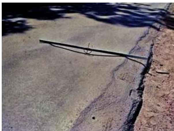
(a) Afundamento de trilha de roda
