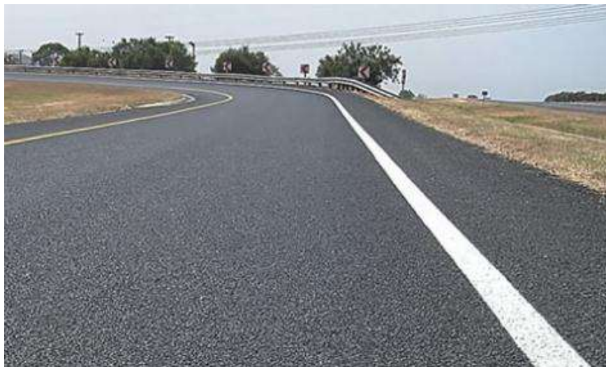
Figura A-1 – Exemplo de pavimento bom
