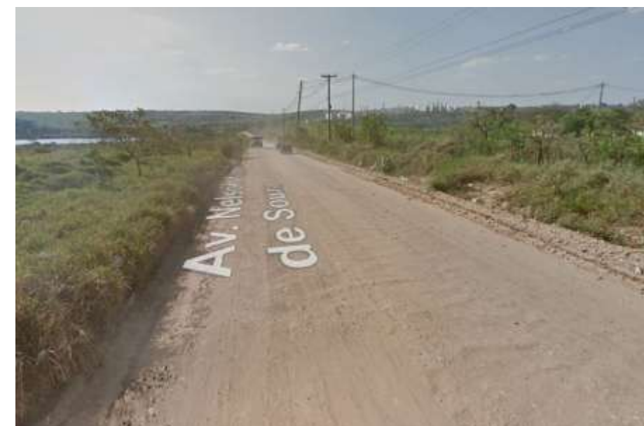
Av. Nelson Ferreira de Souza: ligação perimetral deficitária e escassa nas regiões periféricas do município Fonte: Google Street View (2015)
