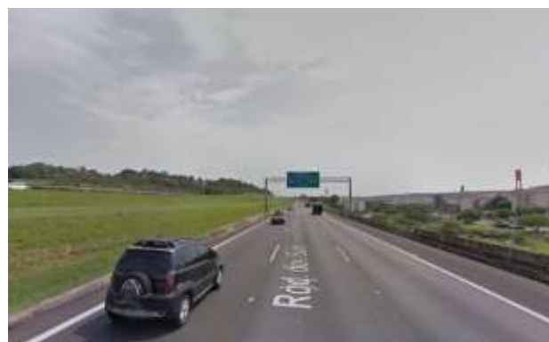
Ocupação lindeira das rodovias Fonte: Google (2015)
