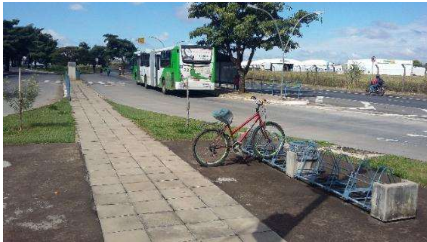
Paraciclo – Estação de Transferência Amarais (Sta. Mônica) Fonte: TTC
