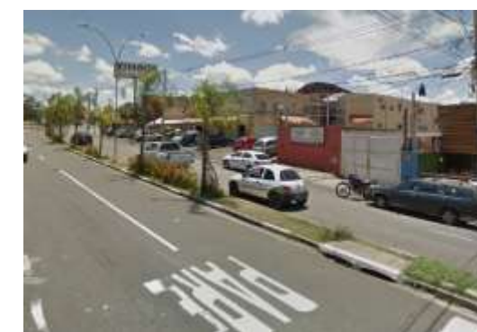
R. Antonio Prado: Estacionamento em leito carroçável (Sta. Rosa) Fonte: Google Street View (2013)
