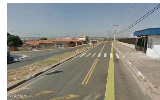
Terminal Itajaí, qualidade da travessia (Itajaí). Fonte: Google Street View (2015)
