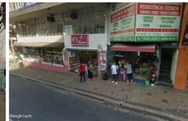
Parada de ônibus de difícil visualização sinalizada por placa na R. Gen. Osório. Fonte: Google Street View (2015)
