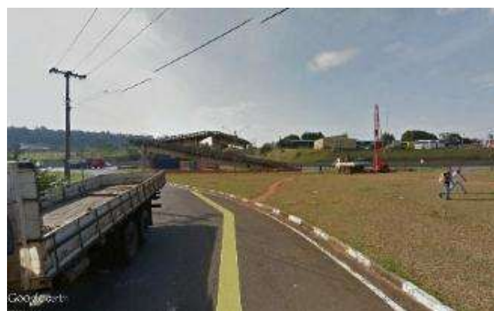
Passarela na Rod. Jorn. Francisco Aguirre Proença. Fonte: Google Street View (2015)
