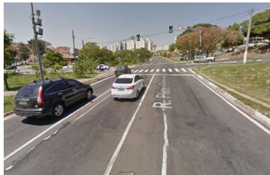
Falta de calçamento e travessia sinalizada - R. Plínio Pereira Neves (Piçarrão) Fonte: Google Street View (2015)
