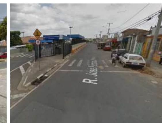
Terminal Vida Nova: Ausência de medidas de moderação de tráfego nos acessos do terminal. Fonte: Google Street View (2015)
