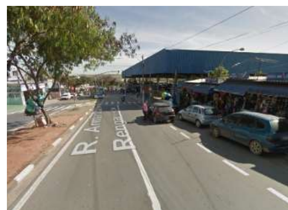
Terminal Ouro Verde: Falta de moderação de tráfego nos acessos do terminal (Ouro Verde) Fonte: Google Street View (2015)
