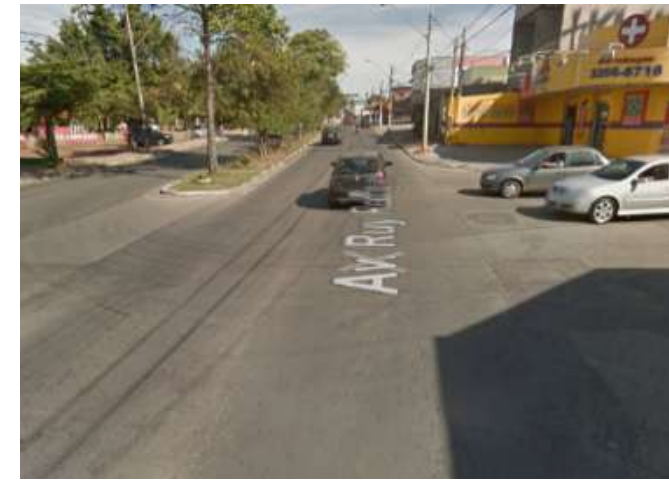
Travessia não sinalizada – e Av. Ruy Rodriguez e Av. Arymana (Jd. Shangai) Fonte: Google Street View (2015)
