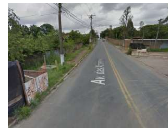
Travessia não sinalizada e falta de calçamento - Av. Amoreiras (Capivari)
