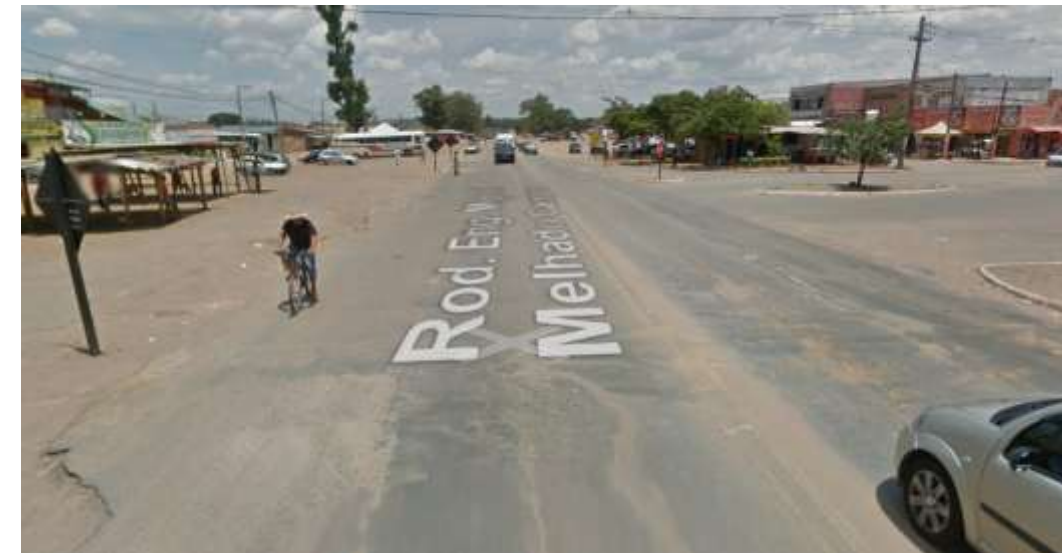
Falta de calçamento e travessia inadequada - Rod. Miguel Melhado (Campo Belo)
