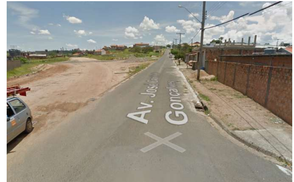
Falta de calçamento e travessias não sinalizadas - Av. José Cristóvão Gonçalves (Icaraí)
