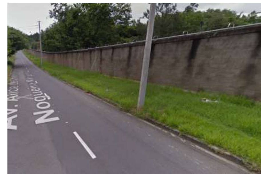
Via murada e sem calçamento – Av. Alice de Castro Pupo Nogueira Matosinho
