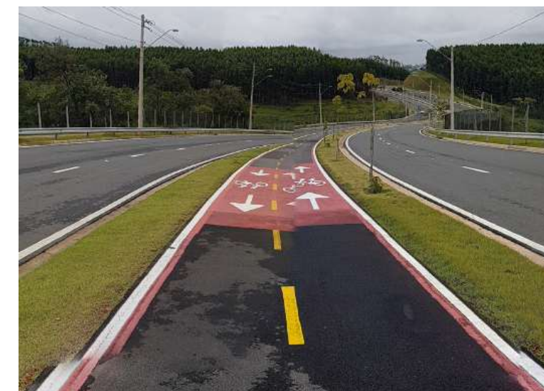
Trecho de ciclovia – Av. Isaura Roque Quércia
