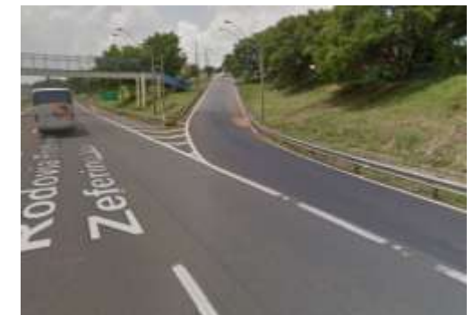
2 – Acesso à ocupação lindeira ao eixo e passarela para pedestres.
