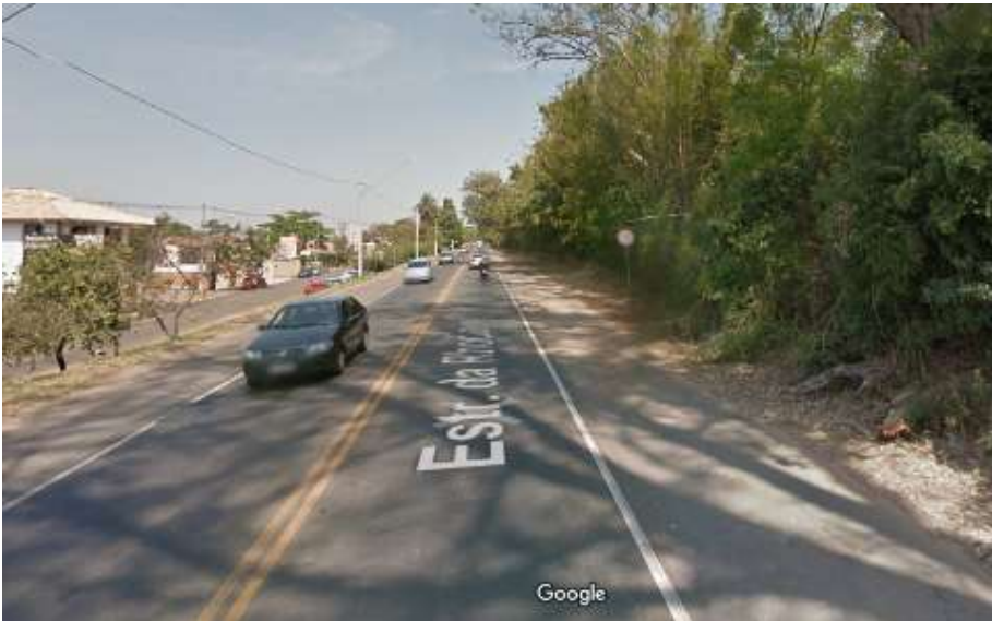
Estr. da Rhodia (Sem estrutura para pedestres e ciclistas) Fonte: Google Street View (2015)
