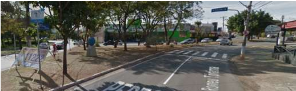
Av. Albino J.B. de Oliveira (Descontinuidade da calçada após a travessia) Fonte: Google Street View (2015)
