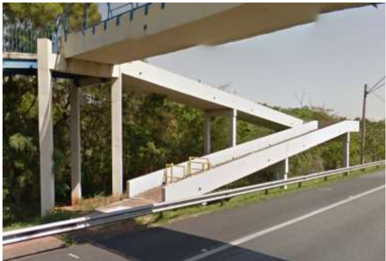
Rod. Prof. Zeferino Vaz (Restrição de acesso à passarela)
