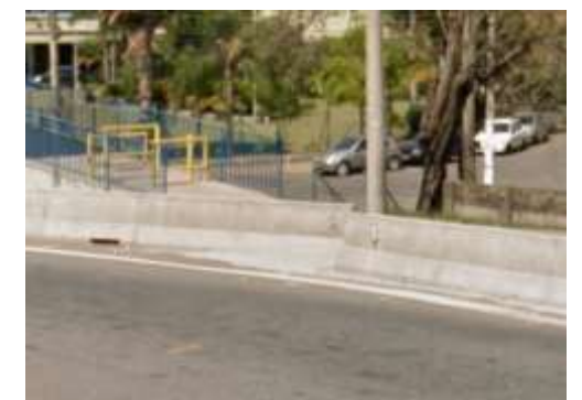
4 – Acesso à passarela utilizando TC.
