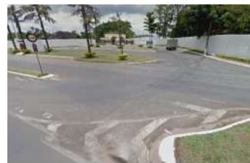
3 – Área de acesso ao condomínio Pq. Rio das Pedras, lindeiro ao eixo. Fonte: Google Street View (2013)
