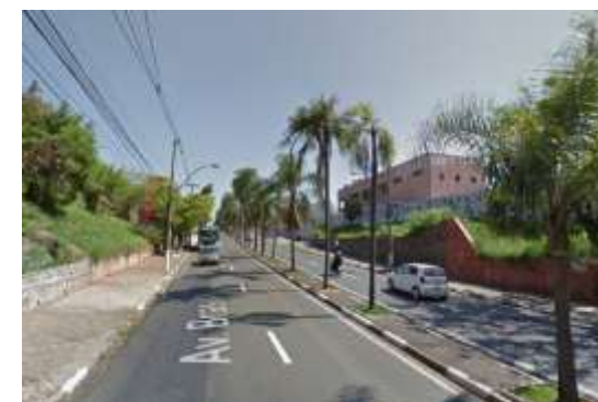
(3) Av. Brasil x Leito Ferroviário da Morgiana Fonte: Google Street View (2016).
