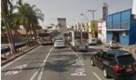
Av. João Jorge (acesso Vd. Cury) Fonte: Google Street View (2015).
