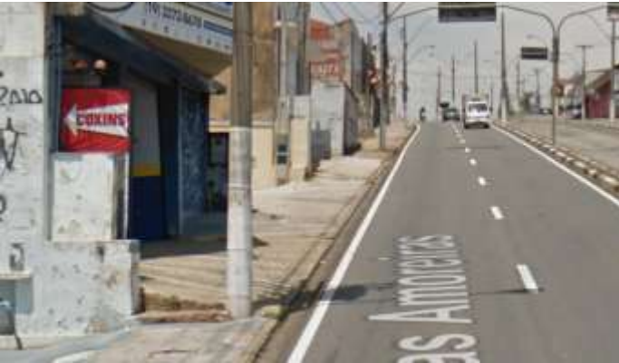
Av. das Amoreiras (Calçada irregular e estreita) Fonte: Street View, 2015
