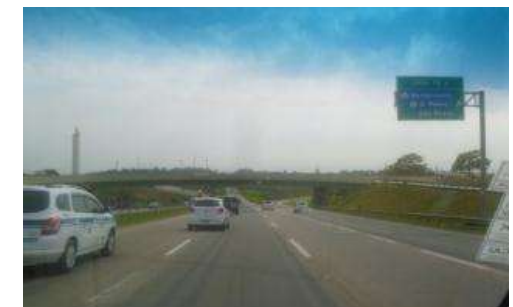
Rodovia Santos Dumont (acesso Rod. Bandeirantes – São Paulo) Fonte: TTC (2016).
