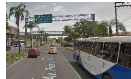
Av. Prestes Maia (sentido Aeroporto)
