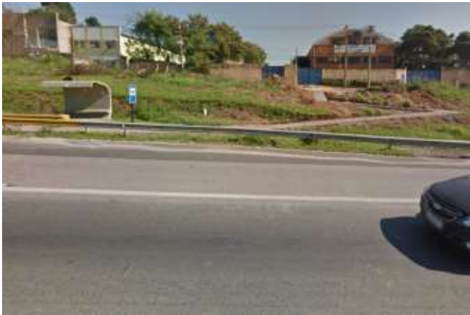
1 – Acesso ao ponto de parada do TC
