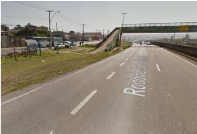
2 – Passarela e ponto de parada de TC.
