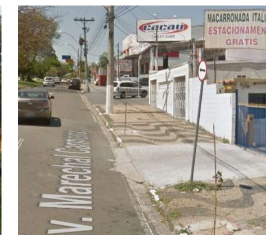
Av. Mal. Carmona (Quebra de padrão nas calçadas) Fonte: Google Street View (2015)
