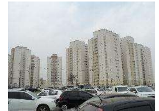
Condomínio próximo à UNIP
