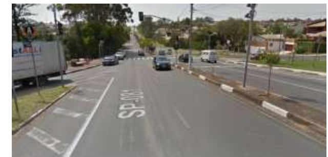
2 – Cruzamento de acesso à Hípica.
