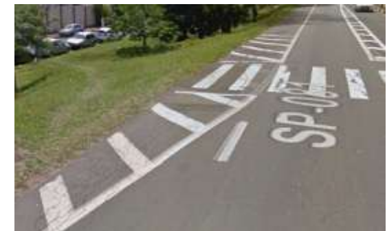
1 B – Travessia em ponto com descontinuidade.
