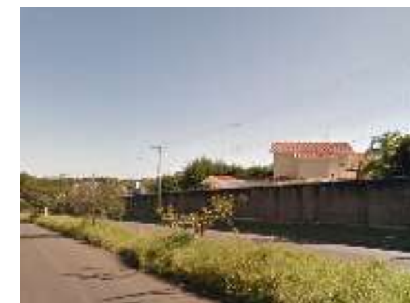
Muro do Condomínio fechado Alphaville Fonte: Google Street View (2012).
