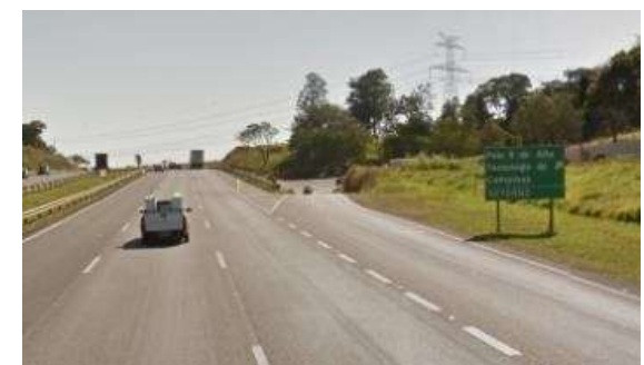
Rod. Adhemar de Barros (sentido Mogi Mirim – acesso CIATEC) Fonte: Google Street View (2015).
