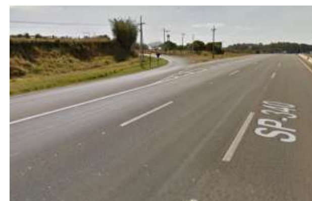
3 – Acesso à Rod. Adhemar de Barros com pista de aceleração. Fonte: Google Street View (2015).
