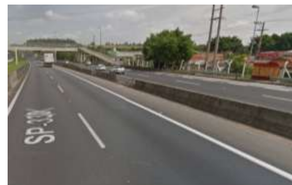
2 –Passarela e ponto de Acesso ao TC.
