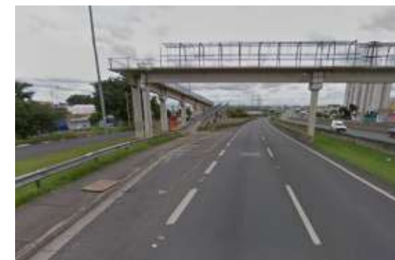
3 – Passarela e acesso ao ponto de TC
