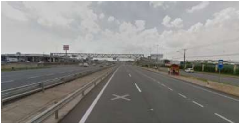
2 –Passarela e ponto de acesso ao TC.
