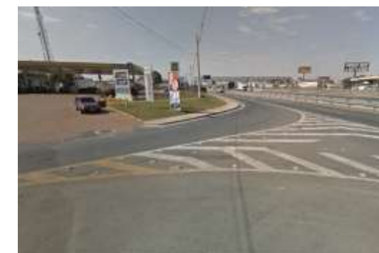
Falta de travessia para o acesso a Passarela Fonte: Google Street View (2015)
