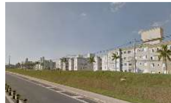
Condomínio Residencial Fonte: Google Street View (2015).
