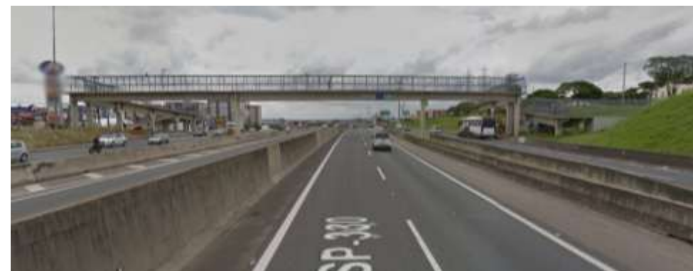
1 – Passarela próximo ao Campinas Shopping
