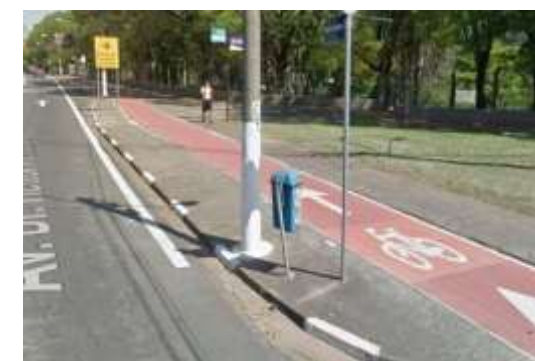
Av. Heitor Penteado (Calçada compartilhada com ciclovia)
