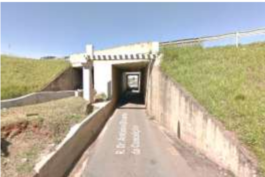
Rod. Dom Pedro I (Transposição estreita para veículos e pedestres) Fonte: Google Street View (2015)
