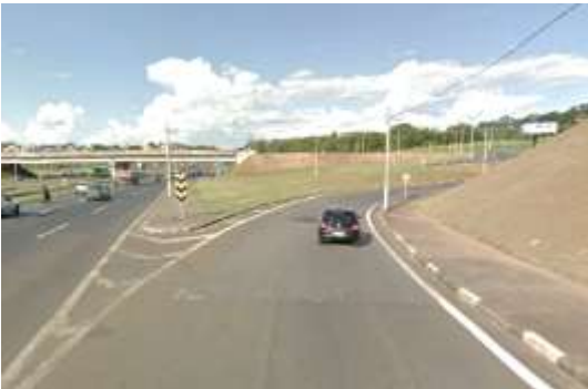
Rod. D. Pedro I (Calçada em acesso ao Shopping D. Pedro) Fonte: Google Street View (2015)
