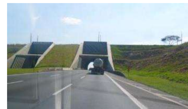
Rod. Adalberto Panzan (passagem sob via férrea)
