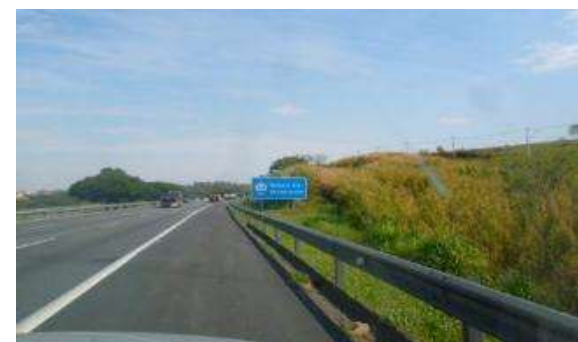
Rodovia dos Bandeirantes Fonte: TTC (2016).
