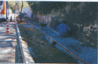
← Linhas e níveis auxiliam na execução
