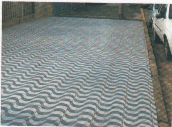
↑ Calçada revestida com material inadequado, que escorrega!
