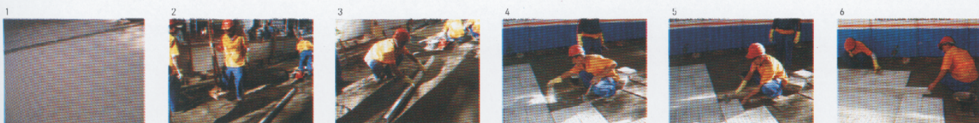
↓ Sequência passo-a-passo da execução do piso
