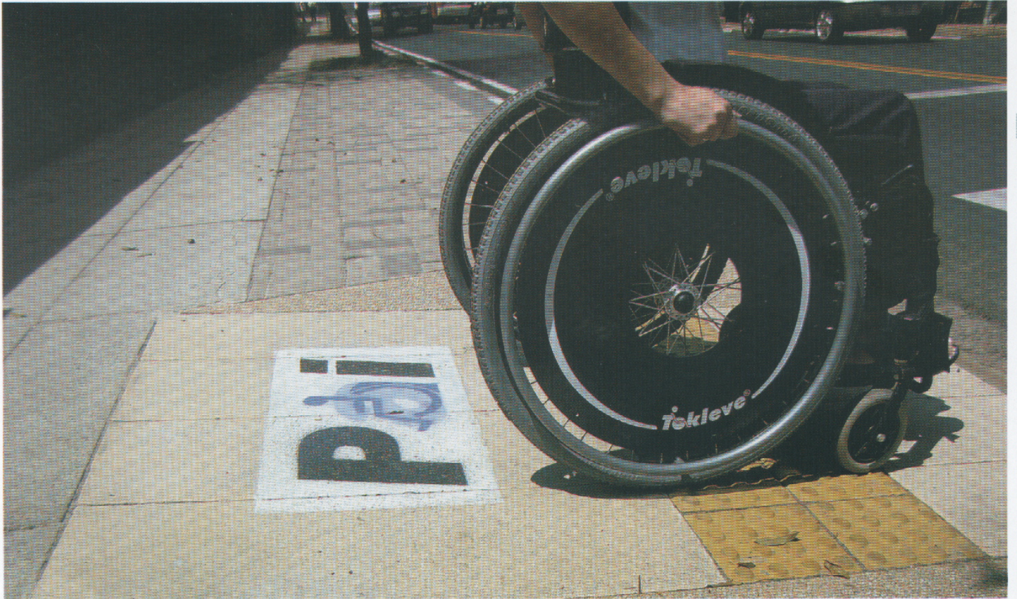
Rampa de acesso em calçada, com piso podotátil, facilita a travessia de pessoas com deficiência
