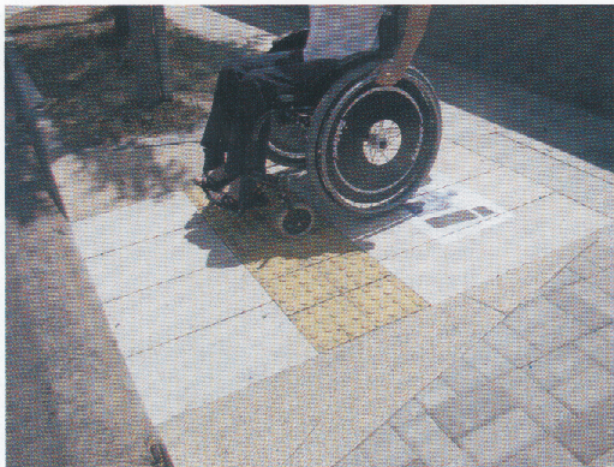
↑ O piso tátil (em amarelo) auxilia na percepção de situações de risco
