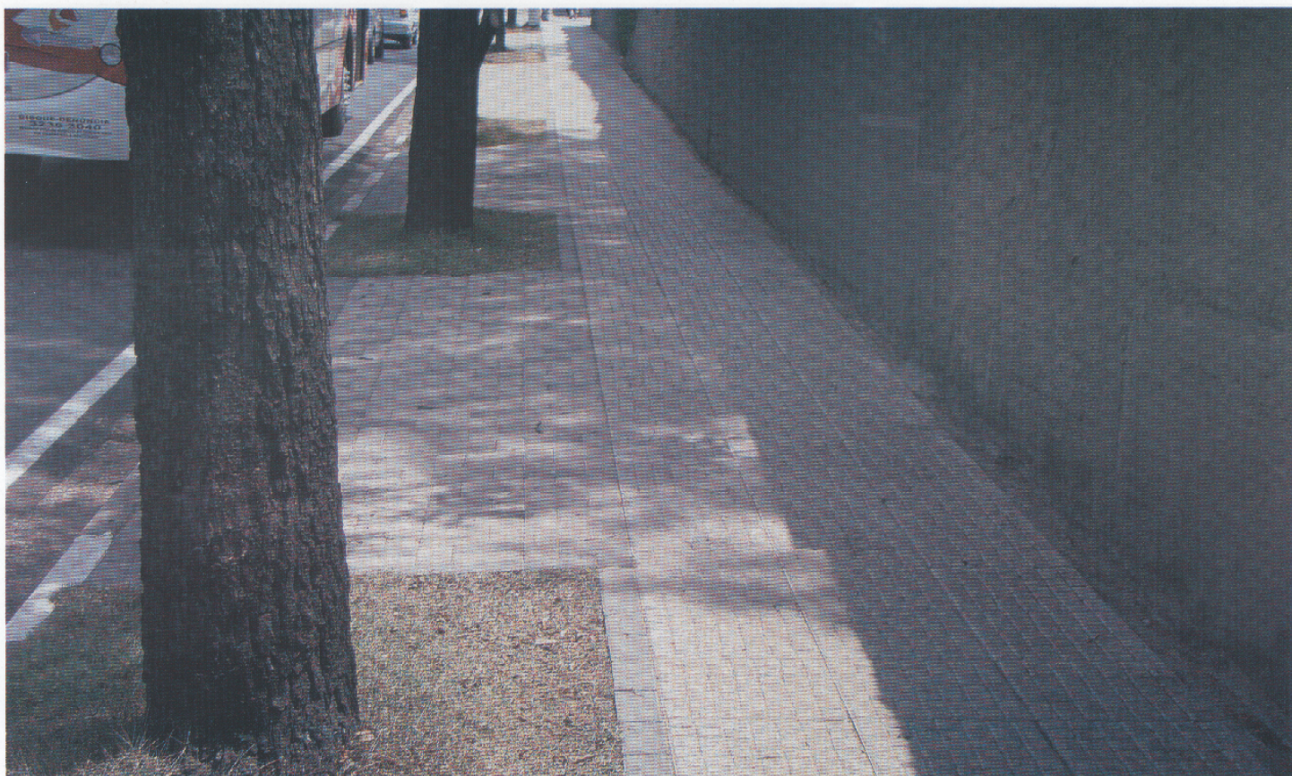
Exemplo de calçada no padrão II, com bloco intertravado e placa vibro-prensada
