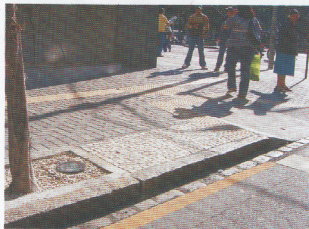
↑ Esquina adequada, desobstruída e com boa visibilidade
