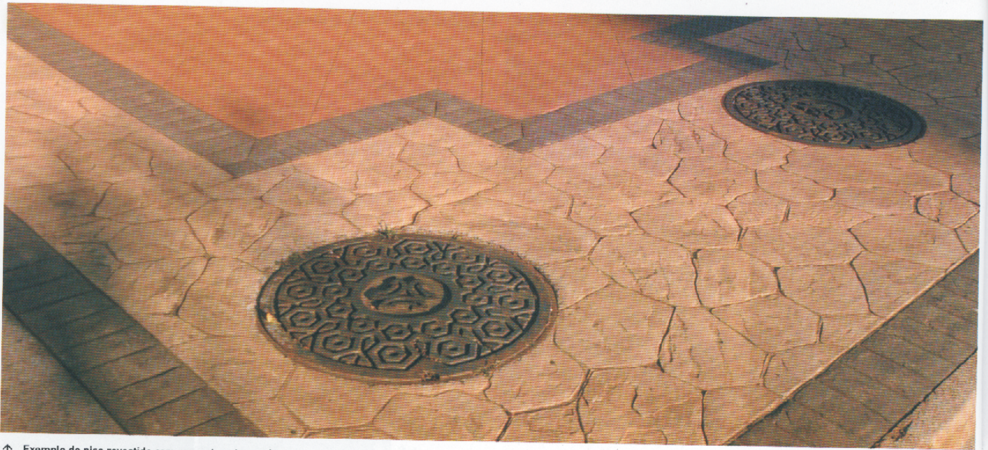
↑ Exemplo de piso revestido com concreto estampado
