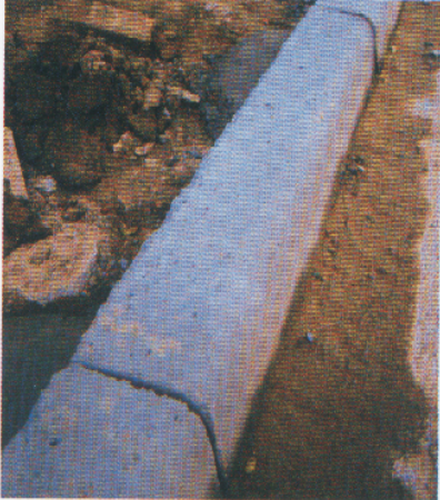
← Guias assentadas junto às sarjetas
