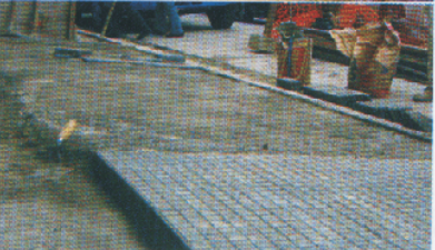
← Contrapiso em concreto com inclinação transversal
