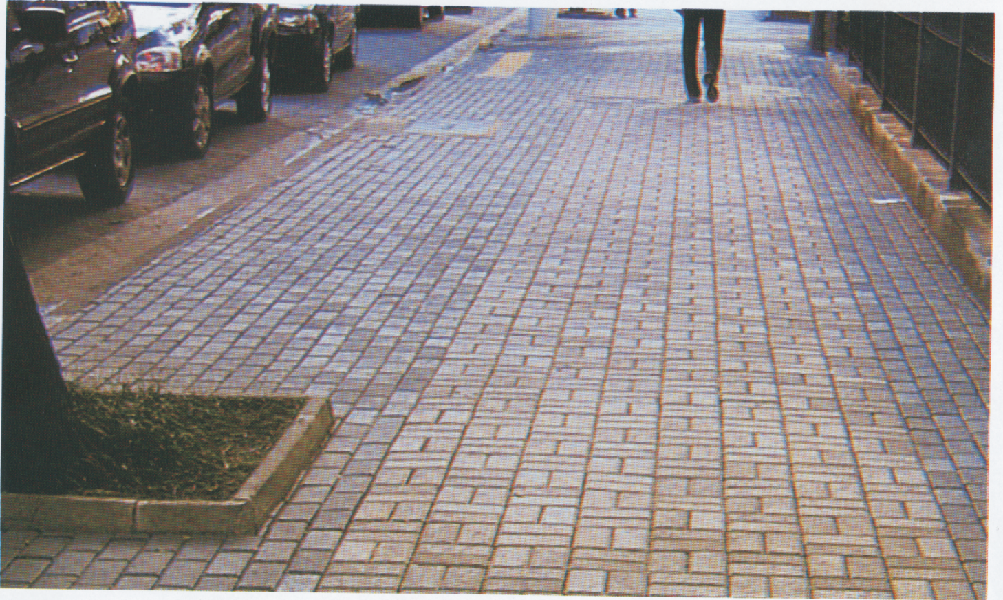
A calçada ideal é antiderrapante, não tem buracos, usa materiais resistentes e contribui para o embelezamento da cidade
