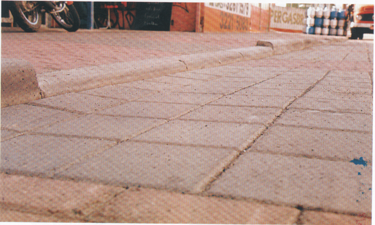
O rebaixamento de guia deve representar uma facilidade para o acesso dos veículos, sem prejudicar os pedestres
