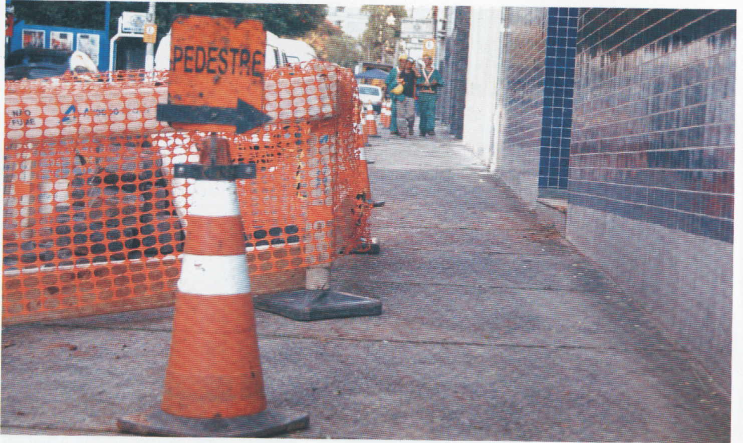
Empresas que executam obras de escavações precisam reparar as calçadas depois de concluídos os trabalhos ver a publicação
