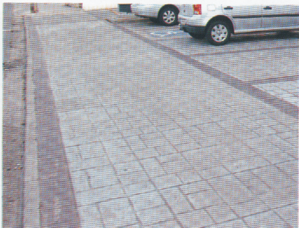
↑ Rebaixamento com inclinação adequada, respeitando a passagem de pedestres
