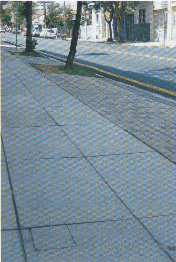
↑ Para que o piso tenha durabilidade e boa conservação, é preciso observar o fluxo de pessoas e interferências no subsolo
