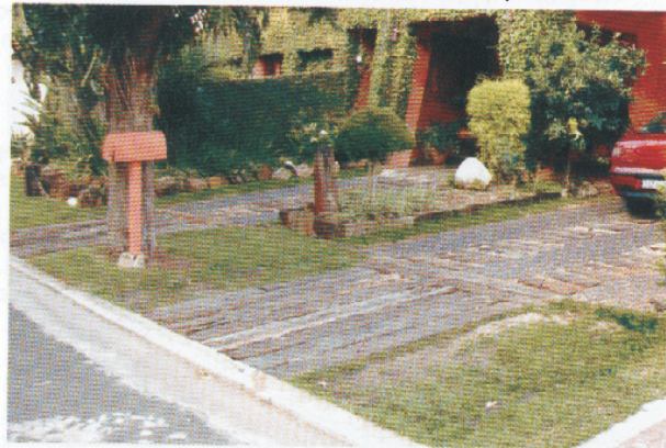
↓ Calçada inadequada, que prejudica a acessibilidade dos pedestres
