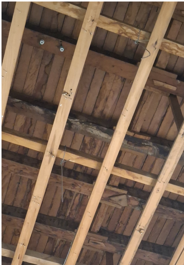
Estrutura do mezanino
