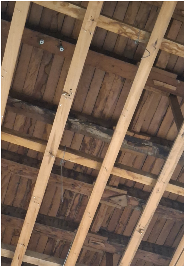
Estrutura do mezanino
